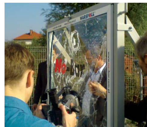
Fot. 2. Szyba po ataku popękana, lecz w dalszym ciągu chroni okno
